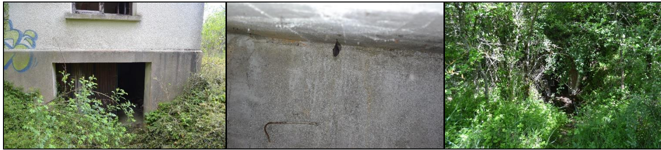
Photo 19 : Cliché de l'entrée de garage d'une ancienne habitation accueillant le Petit rhinolophe, entrée de la cave d'expérimentation(©EXEN)
